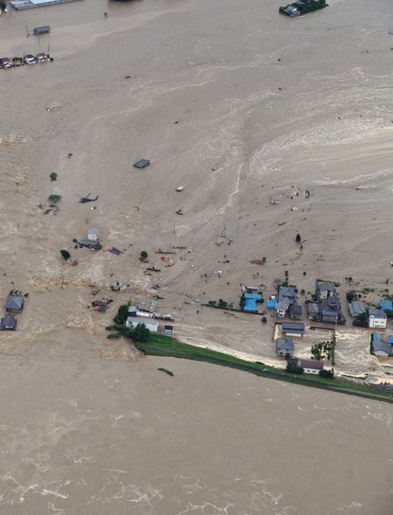
平成27年9月関東・東北豪雨によって破堤した鬼怒川左岸 (提供:国土交通省関東地方整備局下館河川事務所)
