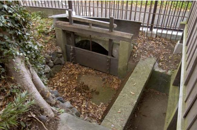
新車は野川の水を利用して稼働していたが、河川改修のために取水できなくなった。左写真の右側が水車、排水溝は向こう側の野川に水を戻す流路。「さぶた」と呼ばれる仕切り版が取水された水の流量を調節する。
