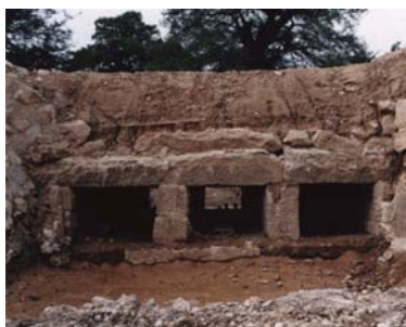
左：成富君水功之碑。 発掘された石井樋（下）と、復元されて稼働中の石井樋（上）
