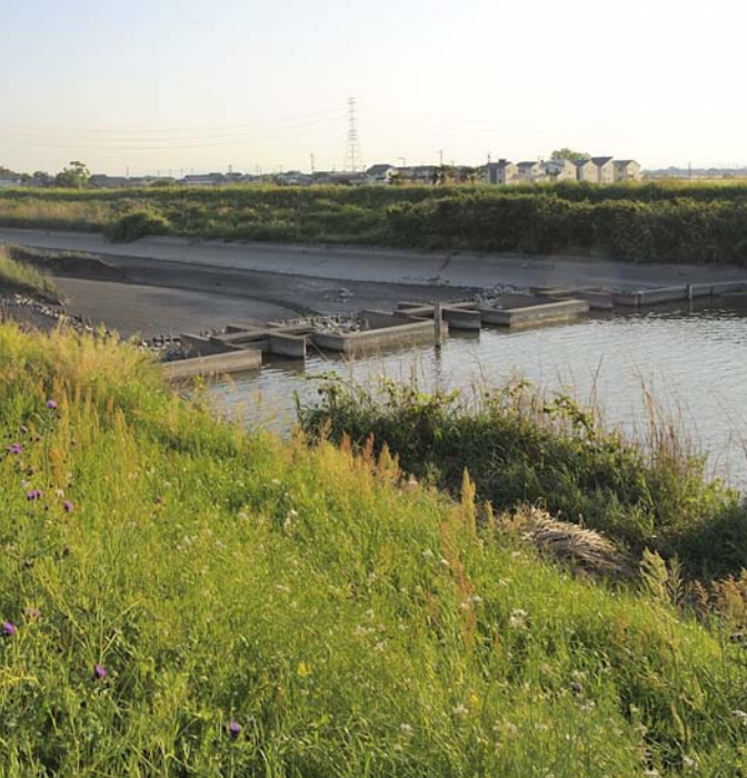
上：お茶屋堰。この固定堰によって、潮がせき止められている。 左上：城原川の水を堰上げ、横落水路で右岸山麓に配水する三千石堰。導水路には、石井樋と同様の仕組みが用いられている。 下：蛤水道と城原川を案内してくださった景観生態研究所の於保泰正さんと「ふるさとの川、城原川を考える会」の佐藤悦子さん。城原川は典型的な天井川で度々氾濫を繰り返してきたが、今も9つの野越し、13の草堰が残っており、於保さんと佐藤さんは河道整備にも地元の知恵を反映させるべき、と運動を続けている。
