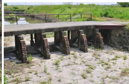
右上：佐賀県千代田町の環濠集落。天然の堀で外敵から守った名残が見られる直島城集落。手前の川は城原川。 上左：城原川は天井川。 下右から：中地江川の高田堰。左の水路がクリークで右の水路が江湖。左側には水位が上がったときに水を送る「野越し」が見える。 ：蒲田津の逆流止め水門。 ：江湖の水位は、満潮になると水田より高くなるが、訪れた午前中（干潮時）には低くなっていた。 下左：右手に広がるのは麦田。二毛作でつくられた麦はビールの原料になるそうだ。
