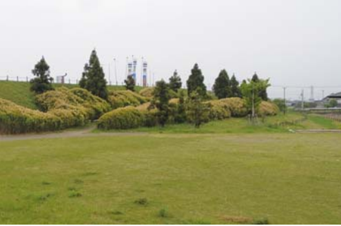
上：千栗堤は中央に粘土状の「ハガネ」を入れてつくられていた。現在は、北茂安千栗土居公園に一部がわずかに残るのみだ。
