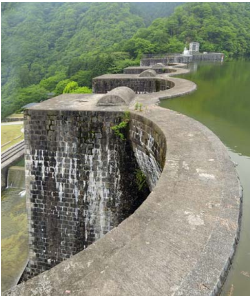
豊総池ダム(香川県)。現存する日本最古の石積式マルチプルアーチダム。多連式アーチダムとしては全国に2つの内の1つ。1997年に国の登録有形文化財(土木構造物)に登録された。度重なる大干ばつへの対策として1926年(大正15)に着工され、1930年(昭和5)に完成。地元住民延べ15万人による人海戦術により、約4年で完成された。
