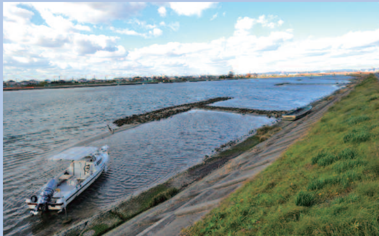
左右ページ最上段：旭川の放水路である百間川の河口水門。右は流下能力を向上させるためにつくった増設水門。ライジングセクタゲートといって、回転することで扉体を開閉させる仕組みだ。左は既設水門（ともに手前が海側）／2段目：Tの字に見えるのがケレップ水制。水の流れを片側に寄せることで、堆砂を防いで航路確保に貢献した。つくられたのは1934年（昭和9）の洪水後。今は干潟の形成に役立っている。
