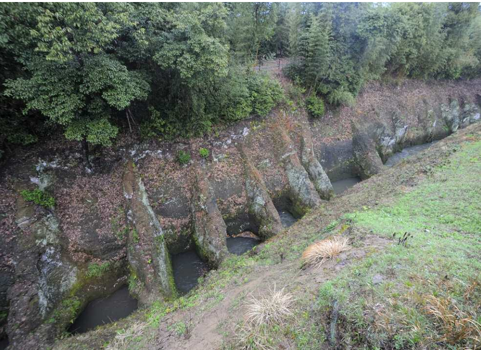
馬場補井手の鼻ぐり。下が模型で左下が現在。かつては手入れもされずに草がぼうぼうとしていたので、見るために降りていくのも命がけだったと言う（左上の写真は岡裕二さん提供の当時の写真）。台地の下だから、ヨナ（火山灰の堆積物）が溜まると手入れができない。そのため水路を掘る際に、隔壁を設け牛の鼻ぐりのような穴を開けて、底の流速が増すことを利用してヨナを排出させた。恐るべし、加藤清正。
