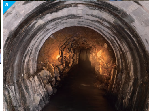
7 芦ノ湖から狩野川流域へ農業用水を送る「深良用水」の取水口 8 取水口から山を貫くトンネルの入口。少し奥に素掘りの跡が見える 9 深良用水は、最終的にはここで狩野川の支川・黄瀬川へ流入する 10 裾野市役所 総務部 行政課の主幹、原 邦臣さん(右)と主事の山田隆蔵さん(左)
