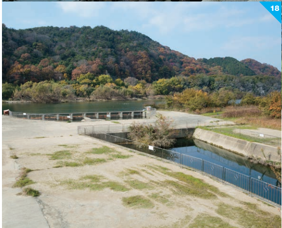
16 揖保川の河口付近に広がる播磨臨海工業地域。素麺のほかにも薄口しょうゆや皮革産業も盛んなのは、揖保川の水と風土があればこそだ 17 工業用水道の水源となる集水埋渠(しゅうすいまいきよ)が地下に埋められている緑地帯。揖保川から播磨臨海工業地域まで続く 18 揖保川の取水口。播磨臨海工業地域まで工業用水として送られている
