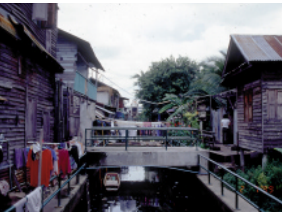
ダーウダウン運河 護岸が建設される以前は、建物の下も水面であった。現在でも船から下岸の店舗に、直接荷揚げしている場面に出会うことがある。
