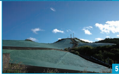
1 屋根に溜まった雨水を雨どいから貯水する三宅島の雨水貯留のしくみ。大きな石垣が貯水タンクとなっている。主に洗濯に使っているという 2 宮古島の東平安名崎(ひがしへんなざき)のそばにある洞窟の湧水。 3 洞窟の中から見た入り口 1 2 3 提供:須山聡さん 4 アメリカの環境保護NGOの「死ぬまでに見るべき世界の絶景13」に、日本で唯一選ばれている青ヶ島。丸で囲んだ部分は向沢取水場の集水面 5 青ヶ島の向沢取水場。山肌をコンクリートで固め、雨を貯水池に溜めることで水問題を解決した 4 5 提供:青ヶ島村役場
