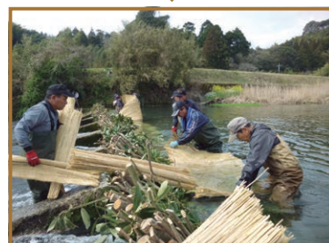
最後は簀をかぶせる。川の水が運んでくる泥や砂、葉などを受け、柴井堰は強度を増していく (提供: 鹿屋市申良総合支所 / 2016年3月16日撮影)
