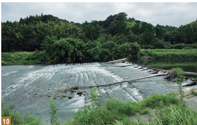
8川原園井堰を考える会の会長を務める泊 義秋さん 9鹿屋市申良総合支所産業建設課の課長、大村勝美さん 10約70年前に築かれたコンクリート製の基礎。水の力で穴が空くなど劣化が進む
