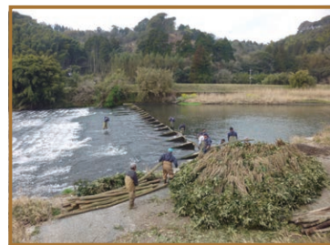
柴架けの作業風景。山のように積み重ねられているのは、出水園さんが束ねた柴
