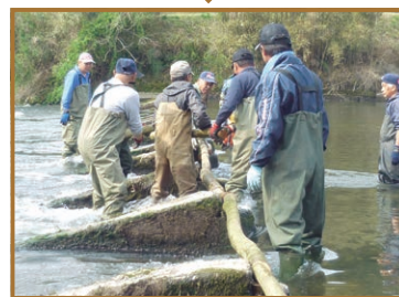
まずはコンクリートの基礎にマテバシイの幹を「横木」として這わせていく
