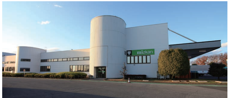
ミツカン栃木工場の外観
