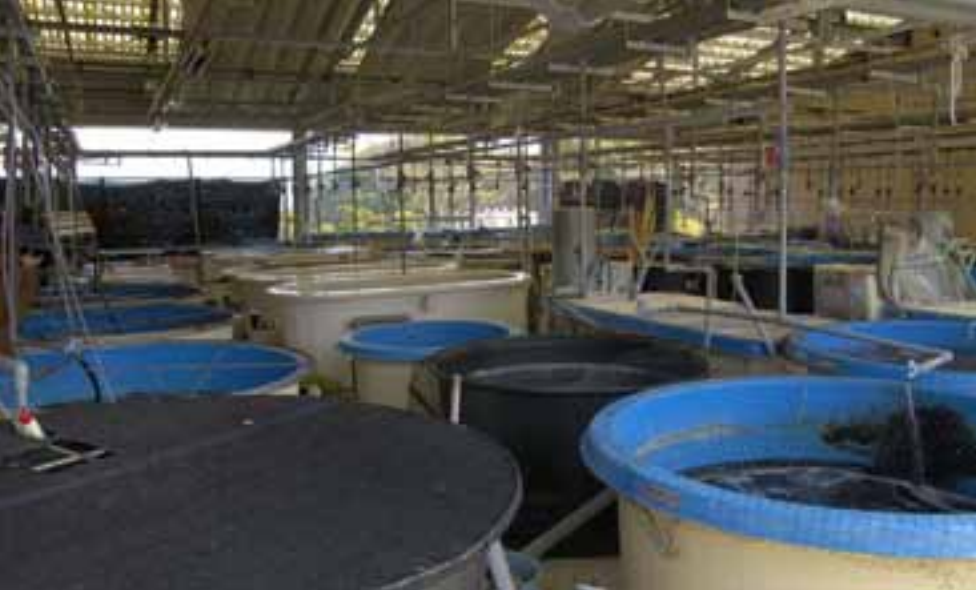
陸上養殖の実験設備「アクアトロン」。天井に張り巡らされた配管で、4種類の水温の海水を送って、実験に用いる。ヒラメは陸上養殖の優良種となっている。海から離れた場所でも、この方法なら養殖が可能。ちなみに南勢では2600t/日の海水を、玉城では5000t/日の淡水を使っているという。温度や廃水の管理がしやすく、環境負荷が少ない陸上養殖だが、電気代がかかるのが悩みの種。
