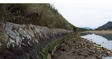
堀川運河そばの広渡川右岸に残る石積み護岸。油津の中心街を守るためにつくられたと思われる
