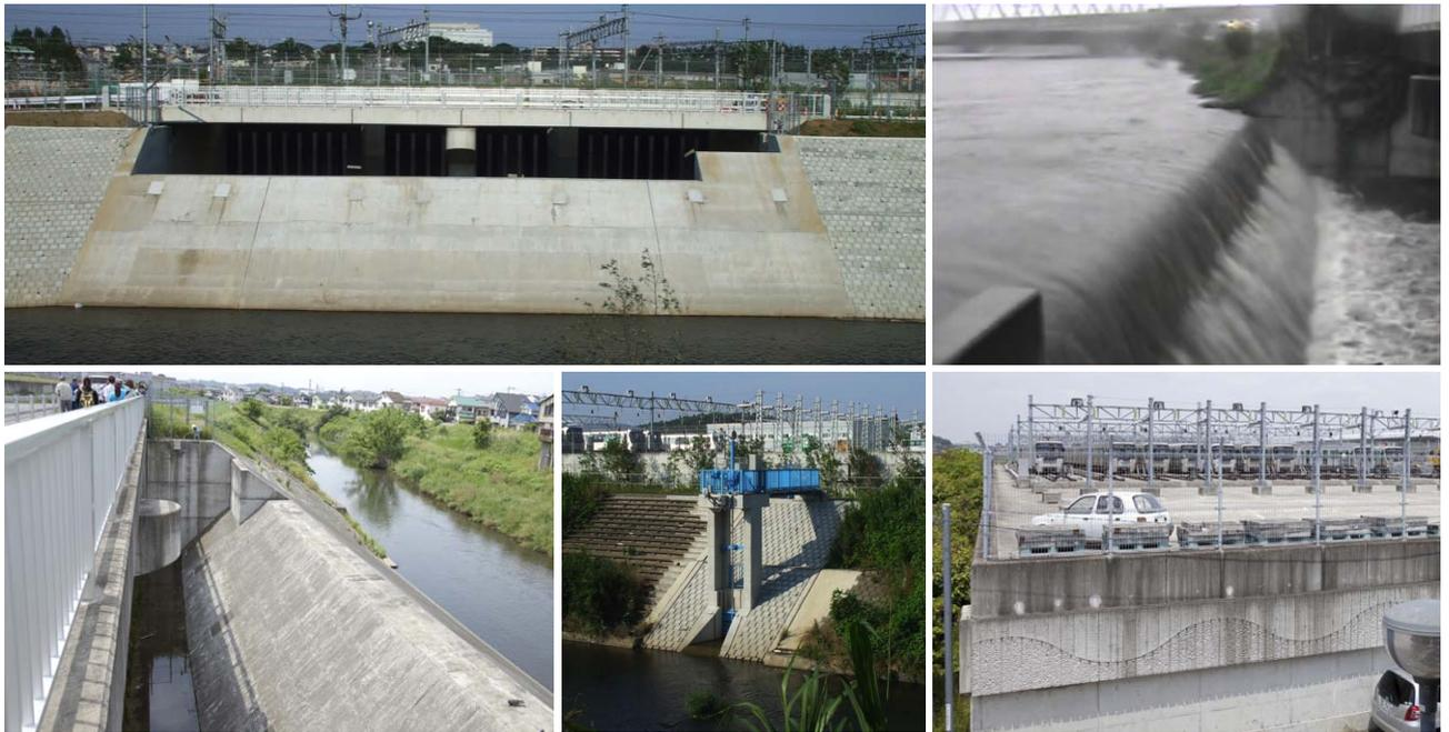
上段左：鶴見川に面した越流堤 右：台風26号による流入状況(2013年10月16日6時頃)(上段2点 提供：神奈川県 横浜川崎治水事務所)
