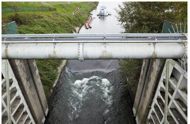
下流から上流に向かって見た閘門。水門を境に利根川と江戸川の水位が違うため、水位を調節して船が通行できる閘門が建設された。閘門の幅は10mで、上下の門を手動で開閉する
