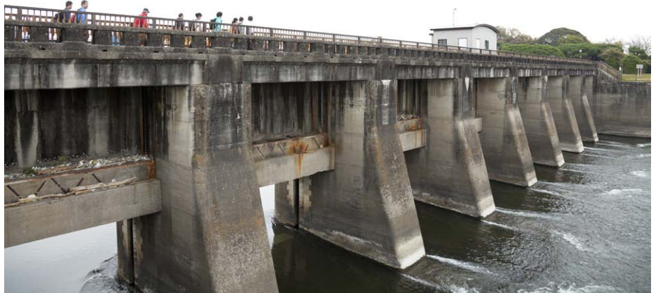
1927年（昭和2）竣工の「関宿水閘門」。水門は8門のゲートをディーゼルエンジンで昇降させる
