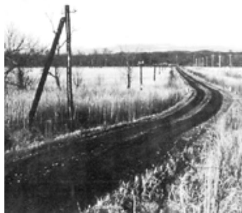
湿地をわたる浮橋 昭和39年（帯広営林局編『造林10年パイロット・フォレストの歩み』昭和40年刊）
