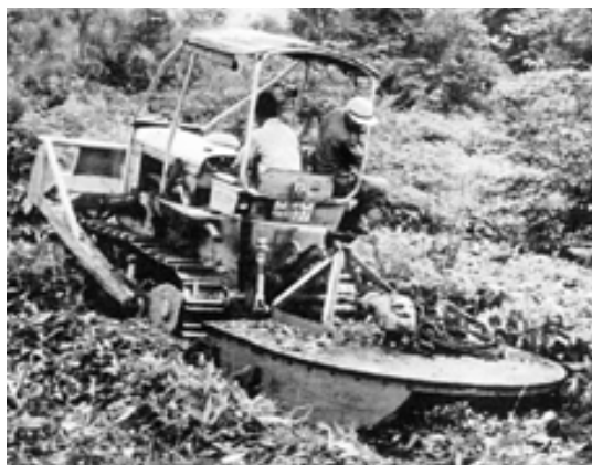
ロータリースラッシャーによる刈払。大きなナタが二枚プロペラの様に回転する。昭和35年（ ）
