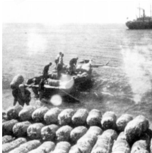
浜から解で沖の蒸気船まで米を積み出す。（大正頃の滑川で）（ ）
