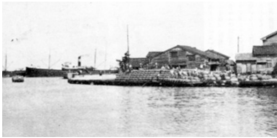
倉庫から出した米を舁に積んでいる最中の東水橋港口(『富山県の産業と港湾』昭和11年発行より)( )
