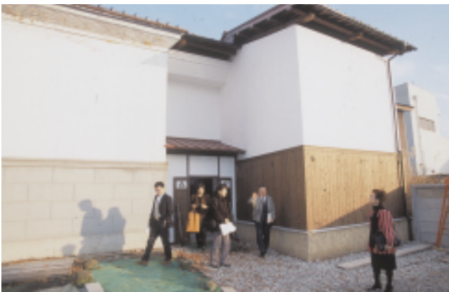
一般公開されている「森屋敷」の河港側出入口。往時の建物の風情を再現している。
