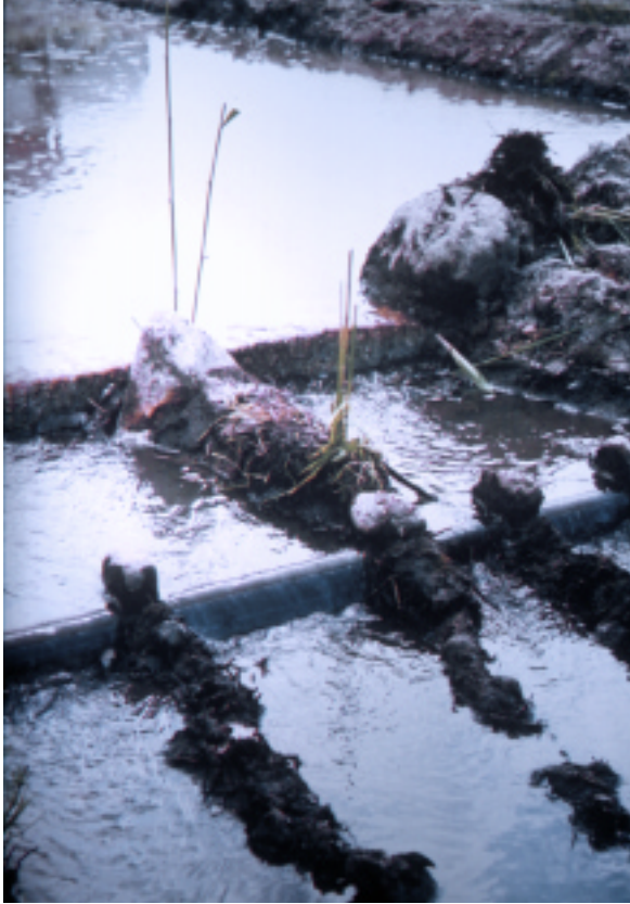
上：田んぼの水入れを公平に行うため考えられた仕掛け。溜池から流れて来る水を田んぼの耕作面積に応じて、石と木で水平に塞ぎ止め川幅を決めて配水した。水を分割して取る、「割取り」と書いて「カトリ」。本誌1号で紹介した香川県満濃池の分水のしくみ「線香水（線香の燃えている時間で配水時間を管理する）」と対比すると興味深い。
