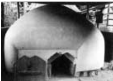
復元された釜風呂。高さ180cmほど。内部は畳み三畳ほどで、床には石を平たく敷き詰めている。
