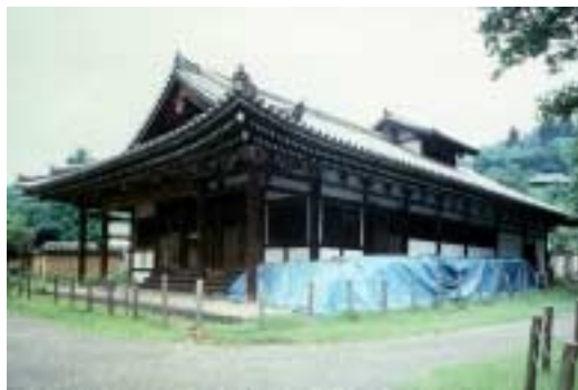
東大寺大湯屋外観 建物は妻入りで西に面し、屋根の前面を入母屋造、後面を切妻造とし、前面一間を吹き放している。湯屋の遺構中最大の規模を持っている。
