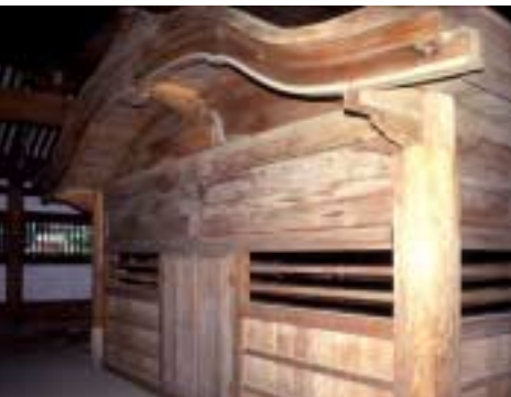
東大寺大湯屋の浴室内部 浴室の中央東寄りに唐破風を持つ風呂屋形が据えられている。
