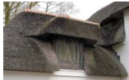
上：デンマークのトラファルト美術館のオフィス。新しい建物だが、屋根は茅で葺かれている。 左上：約120年前に建てられたノルウェーのログハウス。白樺の樹皮の上に土が盛られている草屋根。 左：オスロの野外博物館に移築された、スターヴ教会はすべて木造。屋根は板葺き。製材された小さな板を軒から積み上げるように重ね、タールで仕上げている。修復された新しい部分は、色が薄くなっているが、創建は1200年。 下：デンマーク第3の都市、オーデンセにあるアンデルセンの生家は瓦葺き。 左下：スレートで葺かれた納屋。スレートは自然石なので大きさがまちまち。工業製品以前の素材が持つ、力強さを感じる。 一番下：リトアニアはヴィリニウスのホテルの屋根はトタン。樋が軒ではなく屋根の途中にある。
