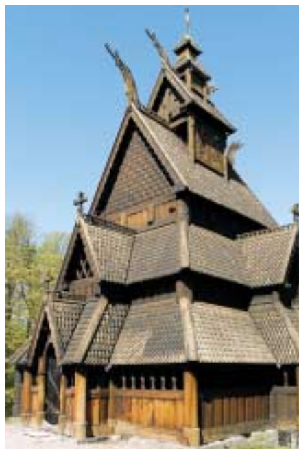
上：デンマークのトラファルト美術館のオフィス。新しい建物だが、屋根は茅で葺かれている。 左上：約120年前に建てられたノルウェーのログハウス。白樺の樹皮の上に土が盛られている草屋根。 左：オスロの野外博物館に移築された、スターヴ教会はすべて木造。屋根は板葺き。製材された小さな板を軒から積み上げるように重ね、タールで仕上げている。修復された新しい部分は、色が薄くなっているが、創建は1200年。 下：デンマーク第3の都市、オーデンセにあるアンデルセンの生家は瓦葺き。 左下：スレートで葺かれた納屋。スレートは自然石なので大きさがまちまち。工業製品以前の素材が持つ、力強さを感じる。 一番下：リトアニアはヴィリニウスのホテルの屋根はトタン。樋が軒ではなく屋根の途中にある。
