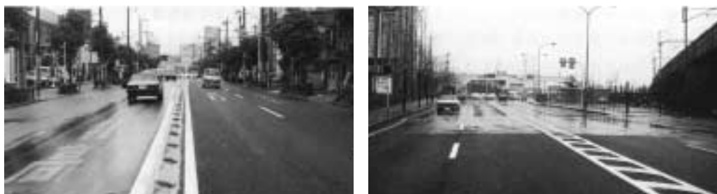
排水機構を持った路面には水が溜まることがなく、黒く見える。水と舗装を考える会編『よくわかる透水性舗装』（山海堂1997）より
