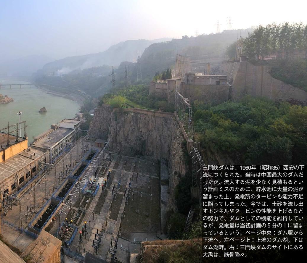
三門峽ダムは、1960年（昭和35）西安の下流につくられた。当時は中国最大のダムだったが、流入する泥を少なく見積もるといふ計画ミスのために、貯水池に大量の泥が溜まった上、発電所のタービンも能力不足に陥ってしまった。今では、土砂を流し出すトンネルやタービンの性能を上げるなどの努力で、ダムとしての機能を維持しているが、発電量は当初計画の5分の1に留まっているという。ページ中央：ダム堰から下流へ。左ページ上：上流のダム湖。下はダム湖畔。右：三門峽ダムのサイトにある大禹は、筋骨隆々。
