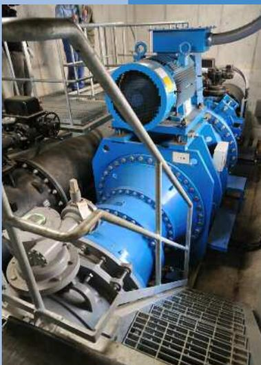
小水力発電施設。2基併設されている。発電容量は270kw(135kw×2)。
