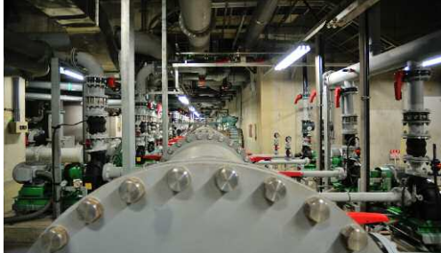
上：縦横に張り巡らされた配管は、いわば血管。万一に備えて水没しないように機械室は2階にあり、自家発電装置も完備。異常を発見するには音や臭いも重要。機械任せにはできない仕事だという。
