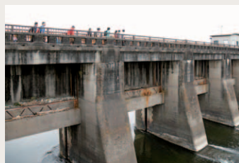
1927年（昭和2）竣工の関宿水閘門（すいこうもん）を見学
