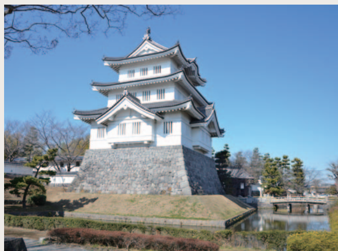
忍城の本丸跡に建てられた三階櫓（模擬）と堀
