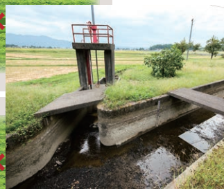
上江用水路の分水ゲート。右が幹線で左が支線。番水のときはここを開閉する
