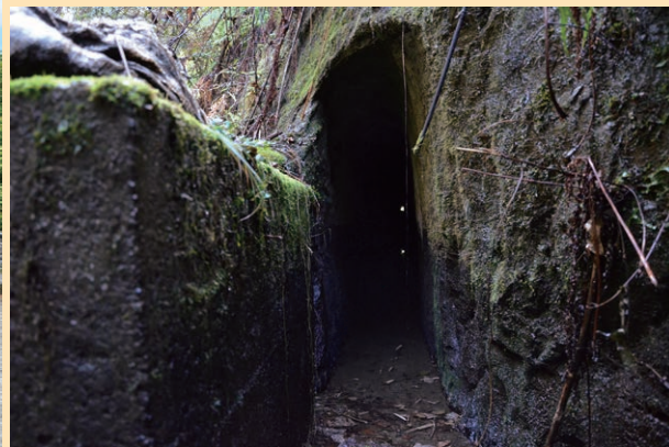
房総丘陵の小櫃川(おびつがわ)周辺に残るトンネル状の用水路「二五穴(にごあな)」。江戸後期から明治初期にかけてつくられた。穴を掘ったのは工事を請け負った小苗村(現:大多喜町小苗)の職人たち。彼らはこの周辺で隧道をいくつも手がけていたが、どういった人たちはよくわかっていない
