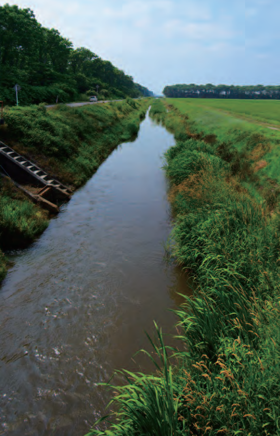
撮影したのは長沼ではなく名寄だが、地中に配管を巡らせる風景があちらこちらで見られた。北海道の低地の土壌改良工事は、現在進行形だ。
