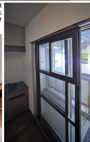
1957年（昭和21）に建てられたRC造り3、4階建ての蓮根団地。ダイニングで食事をする生活を促すために、テーブルが備えつけられた。流しはまだ人研ぎのもの。DK=ダイニングキッチンは南向きに配置された。脇のガラス戸は、上段だけでも開閉できるようにつくられている。風呂桶は木製。
