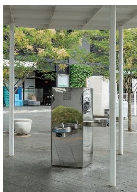
JR熊本市の新幹線口（西口）にある冷水機。熊本市の地下水がいつでも味わえる
