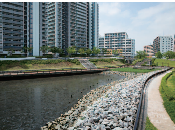
7 かつて運河があった隅田川右岸の荒川区立瑞光橋公園。かすかに残る運河の痕跡と高層マンション群の対比が想像力を刺激する
