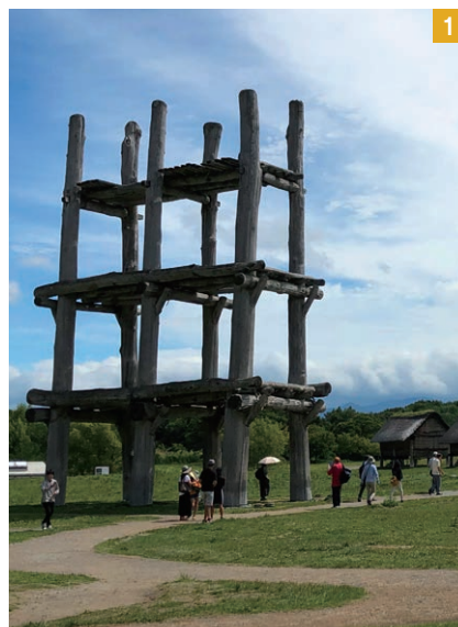
1 三内丸山遺跡に復元された大型掘立柱建物跡。クリの巨木が柱として使われていたという
