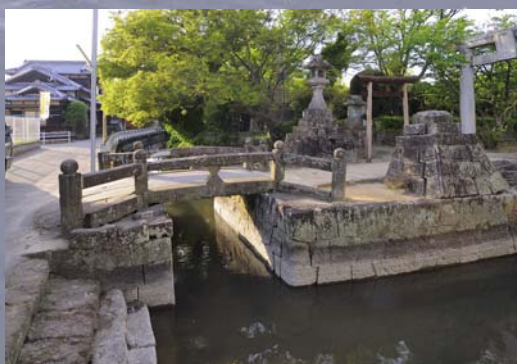
橋の下に見られるのが「もたせ」。掘割に何箇所もつくられたも たせが、水の増加にも対応する。
