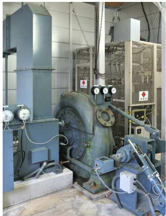
太田川の支流、水内川にある「水内川第一発電所」。発電開始は、1952年（昭和27）5月18日で、今はイムル工業が依託されて管理している。最大出力は170kW。上流部に専用の堰堤を設け、水路で水圧鉄管に導水して流下させている。水車のケーシング以外、すべてリニューアルしているようだ。
