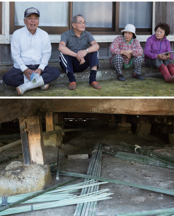
(上)高瀬地区の南さん宅で、毎年のように起こる洪水と水上げ小屋まつわる話を聞かせてくれた住民の方々。左から山口裕久さん、芝 忠夫さん、芝 和恵さん、山口かよさん (下)南さんの母屋の床下。基礎をコンクリートで固めていないのは、浸水した水を土にしみ込ませて抜くため
