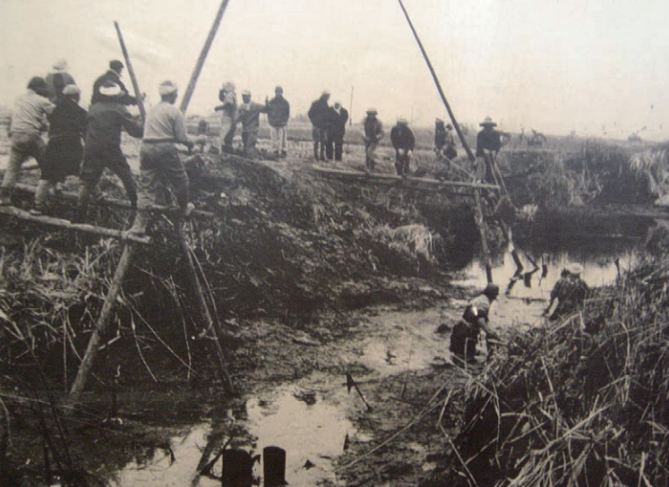
田植え前に用水堀の浚渫と泥土の肥料化を図る「ごみくい」の風景。丸太を組んだ二つの足場の上から「ごみくいおけ」を投げ入れ、田に汲み上げた(提供:佐賀県農業試験研究センター)
