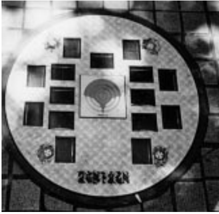
アンテナを機能させるために、マンホールにソーラーパネルが埋め込まれた。(写真提供：東京都下水道局)
