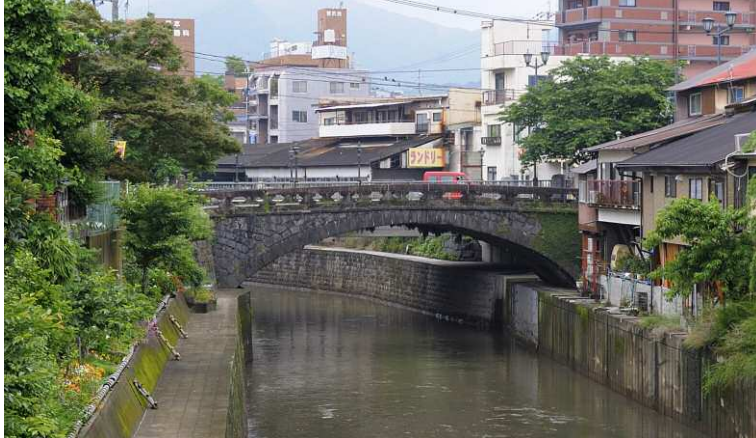
右2点：上益城郡御船町上野にかかる八勢眼鏡橋。江戸時代、熊本と延岡を結ぶ日向往還は、ここから矢部に通じていた。渓谷は深く、増水すると通行ができなくなるため、1855年（安政2）御船の木倉手永で酒造業も営んでいた林田能寛（よしひろ）が私財を投じて架橋。石工 卯助、基平兄弟が通潤橋の次に築造した、長さ62mに及ぶ県下で最長の石橋。
