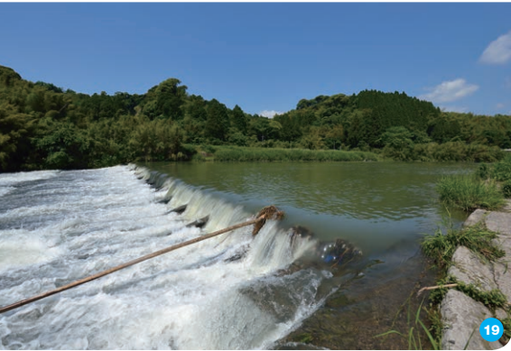
19 「柴井堰」の設置場所。この日は増水していたのであまりよく見えないが、こうした水の流れが運ぶ泥や砂を受けて堰は強度を増す
