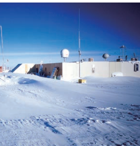
ドームふじ基地：主要部は雪面下にある（提供：国立極地研究所）
