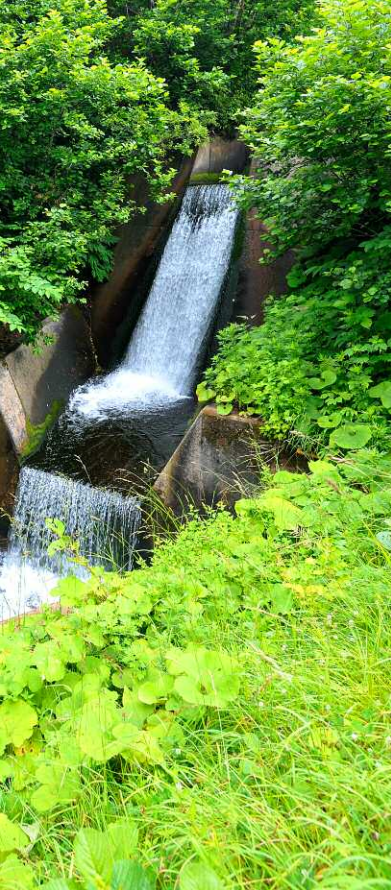
右から：天保堰は、巨大な岩山にトンネルを掘ることで通水している。実際に現地を見て、江戸時代に手掘りで作られたことに驚嘆の思いがした。現在の天保堰は、県営赤川地区灌漑排水事業によって1980～1989年（昭和55～平成元）に改修されたもの。天保用水路トンネル内、向かって左側が水路で右側は作業員のための通路。下：ご案内くださった庄内赤川土地改良区工務部工務課の佐々木正秀さん。
