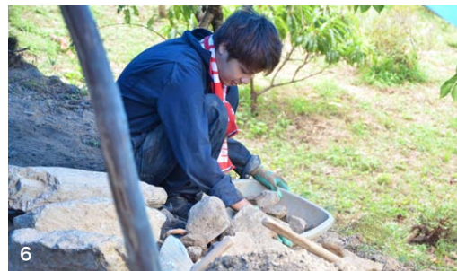
5 取り除いた石は、大きいものは「根石」や「積み石」に、小さいものは「ぐり石」（積み石の裏に入れる小石）として分けて置いておく 6 積みむ人に渡すために「ぐり石」を集める。地味だがスムーズに作業を進めるためにとても重要な仕事だ
