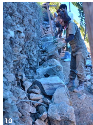
7 石積みの勾配は二分～三分（1m当たり20～30cm奥に入る）がよいとされる 8 あまり整形していない野面石を「乱積み」と呼ばれる規則性のない方法で積み上げるため、石の置き方と角度が重要 9 下から徐々に積み上げていく。積み石は奥（山側）に向かって傾いていることが望ましい 10 「積み石」の裏に「ぐり石」を入れる真田さん。「一ぐり、二いし、三に積み」という言葉があるように、一番大切なのはぐり石、二番目が石の質、三番目が積み手の技術。しっかりとぐり石を入れておくことが耐久性を保つことにつながる
