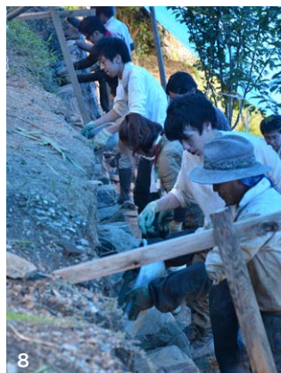
7 石積みの勾配は二分～三分（1m当たり20～30cm奥に入る）がよいとされる 8 あまり整形していない野面石を「乱積み」と呼ばれる規則性のない方法で積み上げるため、石の置き方と角度が重要 9 下から徐々に積み上げていく。積み石は奥（山側）に向かって傾いていることが望ましい 10 「積み石」の裏に「ぐり石」を入れる真田さん。「一ぐり、二いし、三に積み」という言葉があるように、一番大切なのはぐり石、二番目が石の質、三番目が積み手の技術。しっかりとぐり石を入れておくことが耐久性を保つことにつながる
