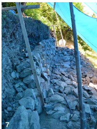
7 石積みの勾配は二分～三分（1m当たり20～30cm奥に入る）がよいとされる 8 あまり整形していない野面石を「乱積み」と呼ばれる規則性のない方法で積み上げるため、石の置き方と角度が重要 9 下から徐々に積み上げていく。積み石は奥（山側）に向かって傾いていることが望ましい 10 「積み石」の裏に「ぐり石」を入れる真田さん。「一ぐり、二いし、三に積み」という言葉があるように、一番大切なのはぐり石、二番目が石の質、三番目が積み手の技術。しっかりとぐり石を入れておくことが耐久性を保つことにつながる
