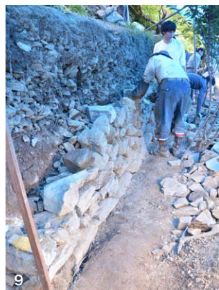
7 石積みの勾配は二分～三分（1m当たり20～30cm奥に入る）がよいとされる 8 あまり整形していない野面石を「乱積み」と呼ばれる規則性のない方法で積み上げるため、石の置き方と角度が重要 9 下から徐々に積み上げていく。積み石は奥（山側）に向かって傾いていることが望ましい 10 「積み石」の裏に「ぐり石」を入れる真田さん。「一ぐり、二いし、三に積み」という言葉があるように、一番大切なのはぐり石、二番目が石の質、三番目が積み手の技術。しっかりとぐり石を入れておくことが耐久性を保つことにつながる
