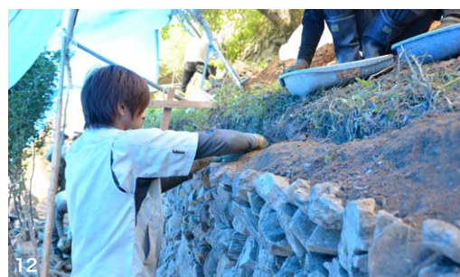
11 ほぼ積み終わった石積み。接着剤を使わない「空石積み」という方法で積む 12 石を積み終わったら、最後は上部に土を入れてしっかり固める
