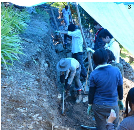
1 石積みの技を残そうとしている石積み職人の高開文雄さん 2 2015年8月17～20日まで実施した「石積み合宿」はこの道路の下が現場だった 3 前日に石積みをいったん取り除き、床掘りからスタート 4 大型の石を「根石」として置いてから積み上げていく
