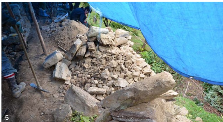
5 取り除いた石は、大きいものは「根石」や「積み石」に、小さいものは「ぐり石」（積み石の裏に入れる小石）として分けて置いておく 6 積みむ人に渡すために「ぐり石」を集める。地味だがスムーズに作業を進めるためにとても重要な仕事だ
