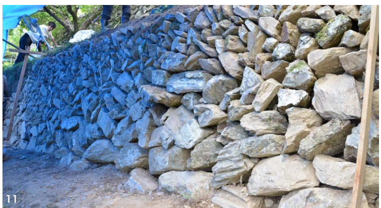
7 石積みの勾配は二分～三分（1m当たり20～30cm奥に入る）がよいとされる 8 あまり整形していない野面石を「乱積み」と呼ばれる規則性のない方法で積み上げるため、石の置き方と角度が重要 9 下から徐々に積み上げていく。積み石は奥（山側）に向かって傾いていることが望ましい 10 「積み石」の裏に「ぐり石」を入れる真田さん。「一ぐり、二いし、三に積み」という言葉があるように、一番大切なのはぐり石、二番目が石の質、三番目が積み手の技術。しっかりとぐり石を入れておくことが耐久性を保つことにつながる
