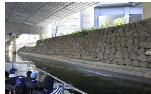
一度解体されて組み直された石垣
