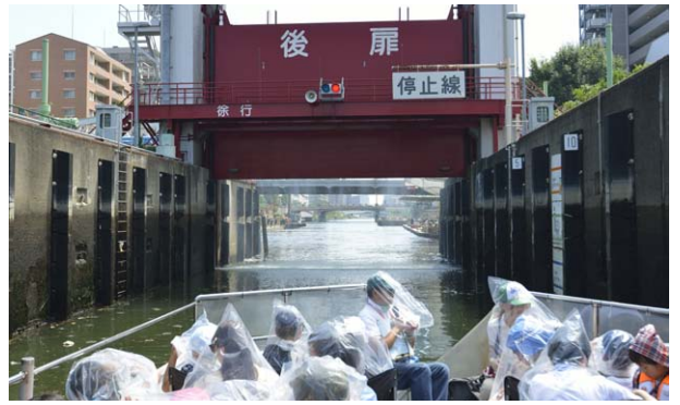
水位調整が終わったのでビニール袋をかぶり扇橋閘門の「後扉」を抜ける
