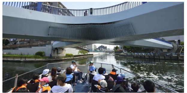
水位調整が終わったのでビニール袋をかぶり扇橋閘門の「後扉」を抜ける
