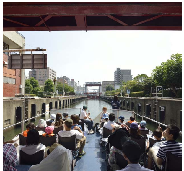
扇橋閘門の「前扉」をくぐる
