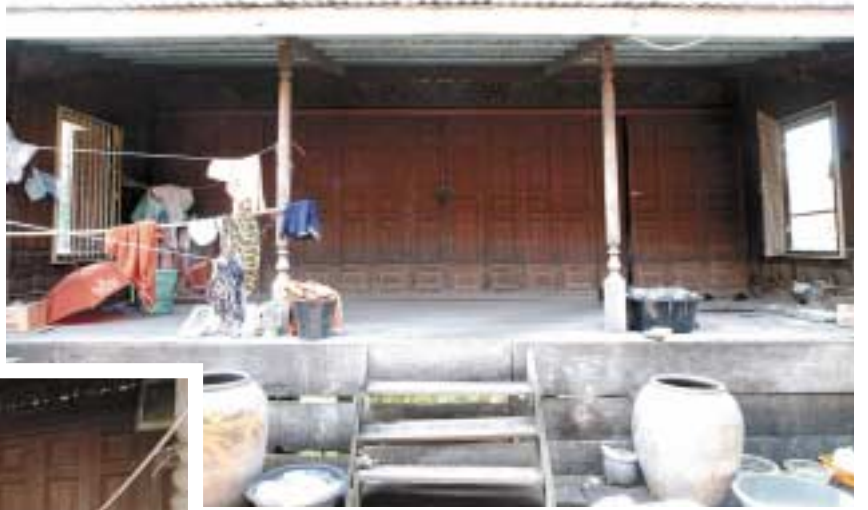
左上：アユタヤーの環状水路に面した高床式住居。他はその内部写真。 左：家が傾いているので、腰高に残る大洪水の痕が、奥に行くにしたがってはいよいよ高くなっているように見える。 上：正面扉についた水の痕が、左の写真より低く見えるのは、床の高さが違うからだ。
