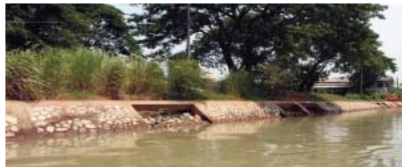
上：個人的に護岸工事がなされた風景。自分の土地を僅かながら広くしていくために、川岸が徐々に迫り出しているのだが、「既成事実をつくってしまえば勝ち」というような慣習が強く、取り締まりの手が届いていないようだ。 左：舟運に利用されている河川には浚渫が必須だ。いたる所で工事が行われている。 下：行政が手がけた護岸。石垣風な部分の内側は空洞で、所々陥没しているが、誰も気にしない。護岸の最大の目的は侵食を防ぎ川底が浅くならないこと。
