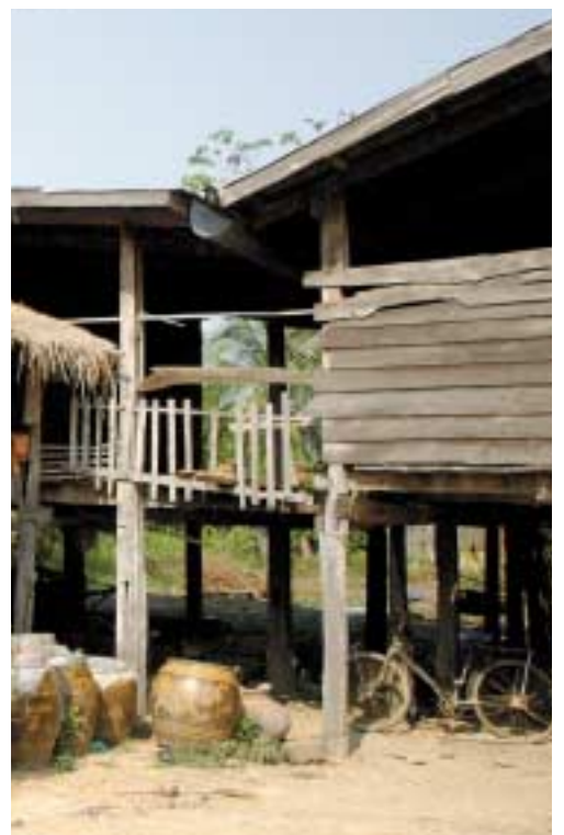
屋根の樋の真下に水がめが設けられている。
