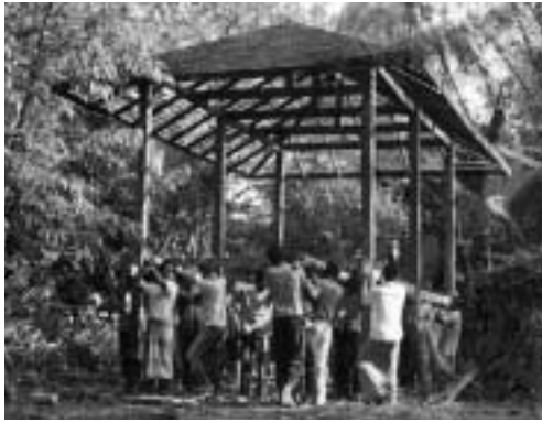
左：増改築、特に移築が多いタイの住宅。壁と屋根仕上げ材を外したら、人力でも動かすことができる、とても軽いものだ。写真の高床式住居は、3kmの距離を運ばれていった。 Pierre Le Roux The Journal of the Siam Society Vol.86 , JSS, 1998 より 右：浮き家の勝手口。壁は竹を網代編みしたもの。 下中央：浮き家の洗面所は上流側のデッキ。写真の奥には、まな板スペースもある。 下左：川は画面左から右に向かって流れている。その家にとって上流側に設けた洗面所やまな板スペースも、隣接した家の下流側に設けたトイレの真向かいということになることが多い。
