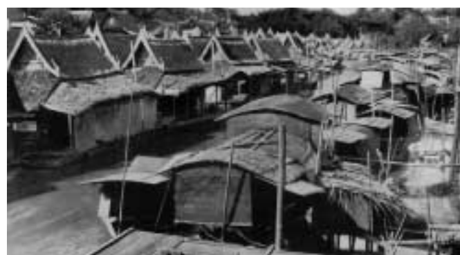
19世紀中頃のアカタヤー。流れの向こう側に見えるのが、竹の上に深く藁葺きの浮き家。手前は丸屋根のボートハウスで、屋根の素材は板材と思われる。ともに建物の間には杭が立っている。Karl Döhring, The Country and People of Siam, Land und Volk , 1923より
