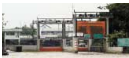
バンコク市内のチャオプラヤー川。トンブリー側の水路の入り口にある水門は閘門。チャオプラヤー川の堤防は高いが、トンブリー内部は水位を低く押さえなければならない。
