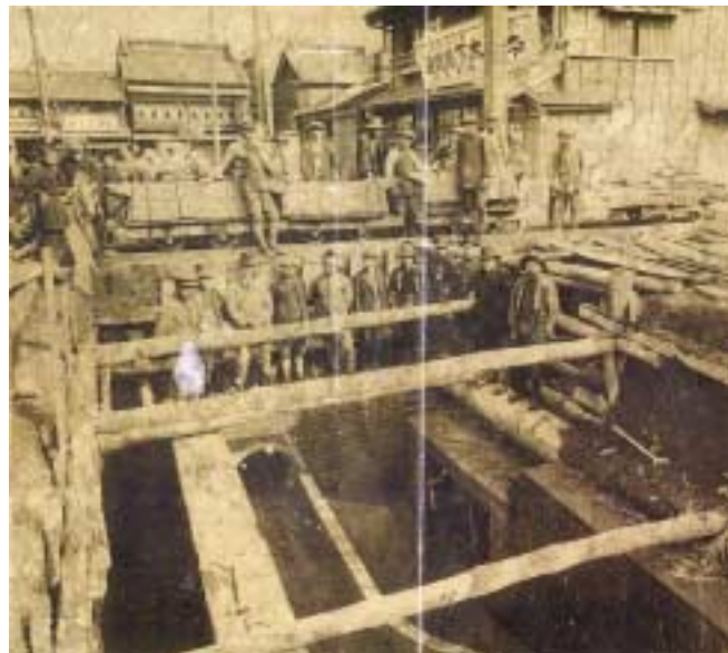
上：1919年（大正8）～1921年（大正10）に行われた、現在の和泉橋（神田川にかかる橋）付近の下水道工事。現場は大雨のとき、下水管内に造られた堰を越えた下水が、神田川に流れ出るようになる「分水堰」の築造工事。『第七回東京市下水道事業概要』より 下：東京市時代の芝浦下水処理物のシムプレックス式曝気（ばっき）槽。
