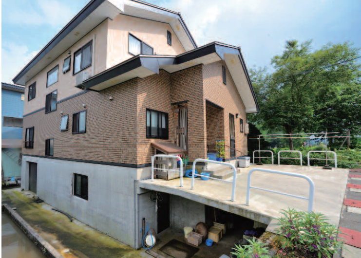
左：大羽賀邸。傾斜地に建つため、駐車スペースに利用できないことから、基礎部分の一部を雪室にした。下段右：倉庫として使われている空間と雪室との境には、標準設計の指示通りに業務用の冷蔵庫が使われている。下段中：調整室は優秀な冷蔵庫。下段左：室内の空気を雪室に送り込むダクト。
