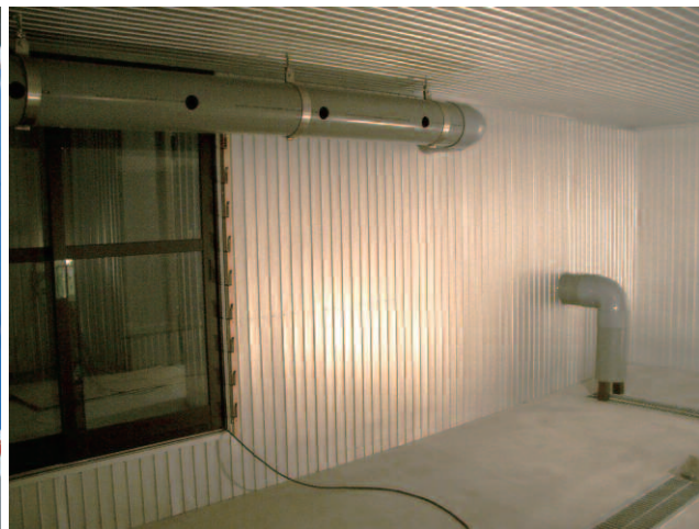
上段：基礎部を高くして雪室に利用している大羽賀邸。家庭用除雪機による初めての雪入れは、2010年（平成22）3月13日。約31tの雪が入れられた。下右：雪を入れる前の雪室内のダクト配管の様子。このダクトを通り、各部屋にクリーンな冷気が送られる。下左：利雪住宅の衆知と普及のために、大羽賀さんの家の前に掲げられていた看板。
