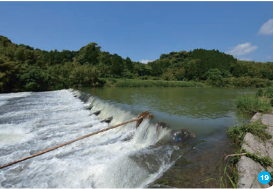
19 「柴井堰」の設置場所。この日は増水していたのであまりよく見えないが、こうした水の流れが運ぶ泥や砂を受けて堰は強度を増す
