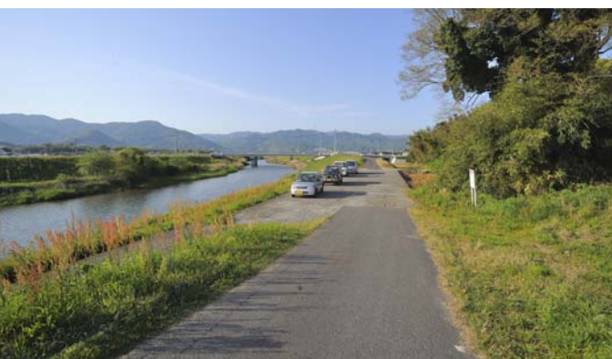
下：堤防が一部低くなって（自動車が進んでいる所）野越しになっている。/下左：集落の家々は、水路で囲まれている。水路上に川端が設けられていた。
