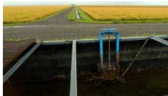
用水路に波形のコルゲート管を使っているのも、軽くて沈下しづらから、という経験から出た知恵。(コルゲート管用水路)
