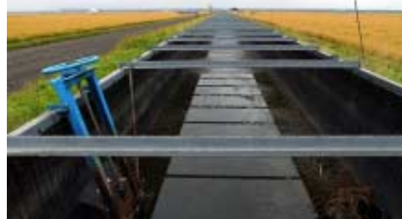
用水路に波形のコルゲート管を使っているのも、軽くて沈下しづらから、という経験から出た知恵。(コルゲート管用水路)
